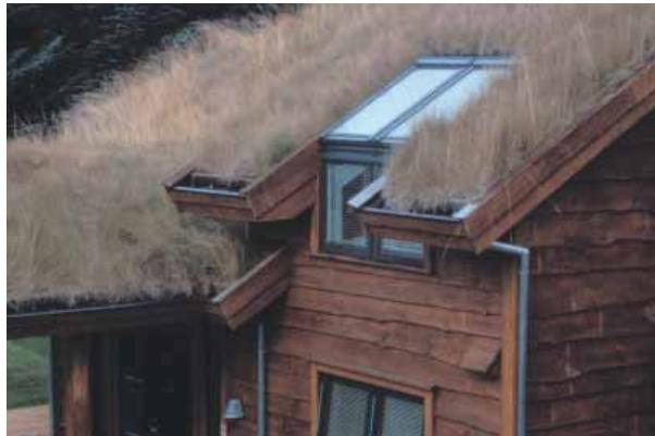
В таких кровельных конструкциях мембрана под природным материалом обеспечивает герметичное уплотнение вокруг окна. Мембрана укладывается от поверхности кровли к сборной платформе и наверх вдоль боковых сторон коробки по всему периметру окна.
